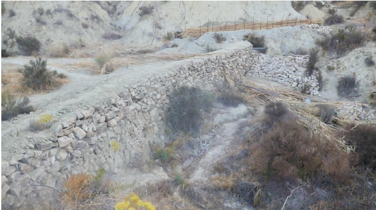
Zomer 2019: Dam in waterretentie landschap
